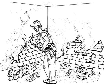
Eventuell ist es hilfreich, wenn Sie die Gipsverkleidung zumindest an einer Seite der Wand entfernen, und zwar vom Boden bis einige Zentimeter über dem höchsten Wasserstand. Dies sollte vor allem dann in Betracht gezogen werden, wenn die Wände Holzelemente enthalten, die faulen können, wenn sie nicht vollständig austrocknen.
